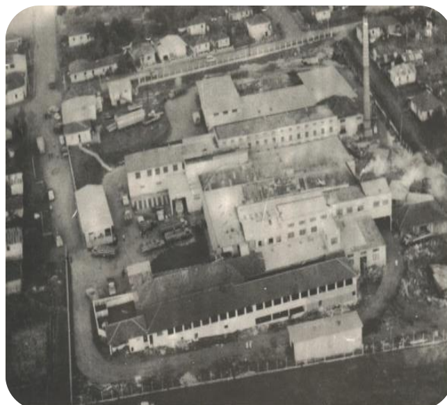
FIGURA 04: VISTA DO FRIGORÍFICO DA DÉCADA DE 60 FONTE: MUSEU, WÜLSON JEOVAH LÜTZ FARIAS, 2014.
