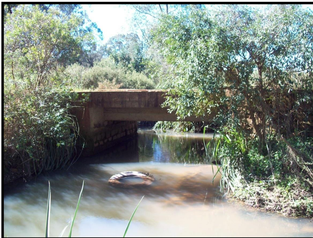
Figura 01: Localidade do Lagoão com pneu descartado inadequadamente no rio. Fonte: Trabalho de campo 2013.
